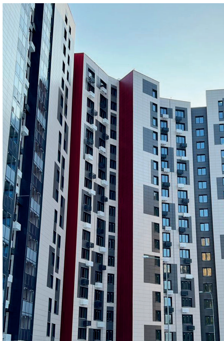
Жилой комплекс «Домодедово Парк»
